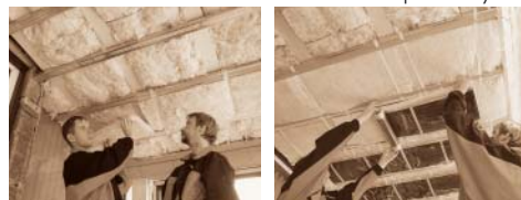
Ilustrační foto montáže ECOFILM C na kovové stropní nosníky
